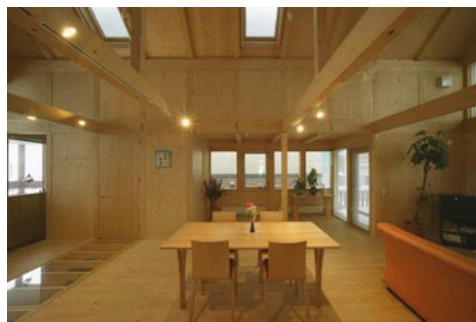
写真1 トドマツ内装用合板の施工例
