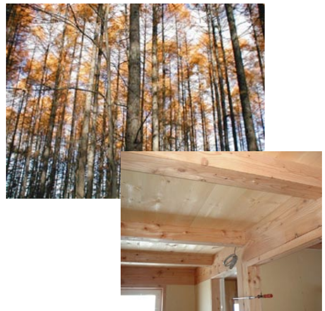
カラマツ林(上)と建設中のカラマツ住宅内部(下)
