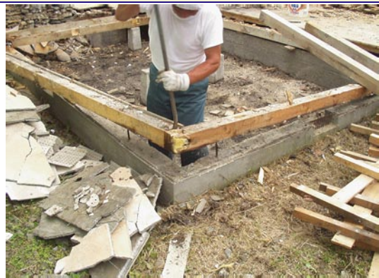
CCA 処理された土台の分別
