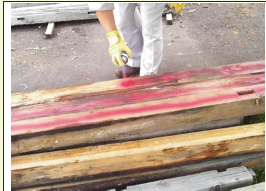
分別した CCA 処理木材のマーキング
