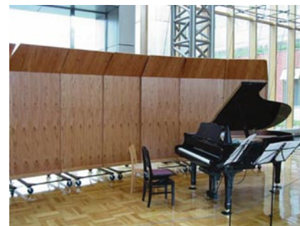
内装用合板の利用「反響板」
