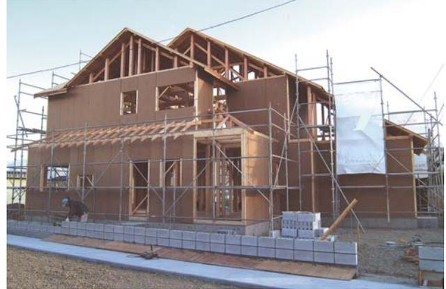
写真1 耐力壁に用いられた構造用MDF
