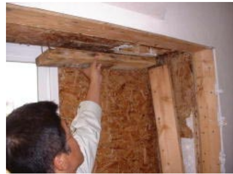
写真9 窓枠部材 (室内側) ※高含水率状態にあるが腐朽はしていない
