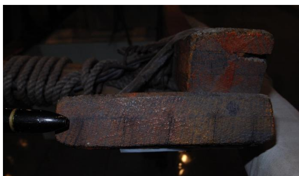
写真2 ラミナを接着して造られた部材
