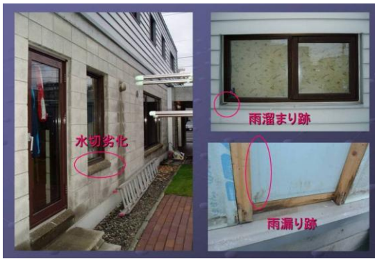
写真2 改修前の状況
