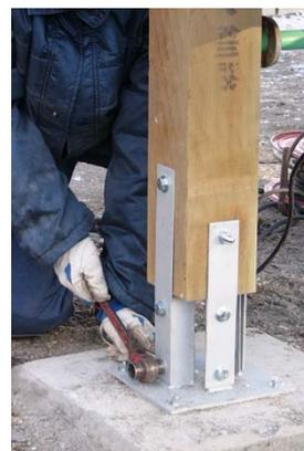
写真7: 平金物による柱の固定
