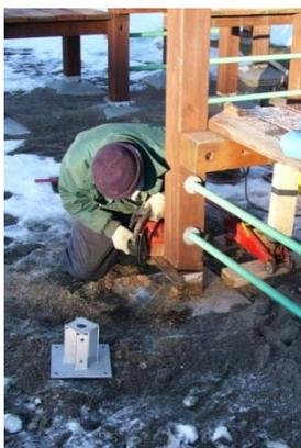
写真5: 腐朽部位の除去
