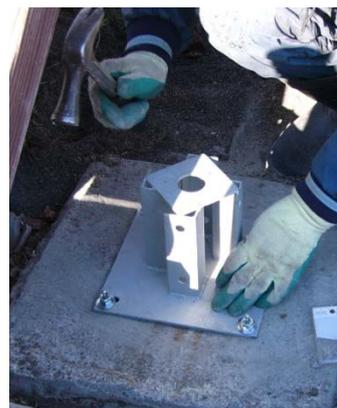
写真6: かさ上げ金具の取り付け
