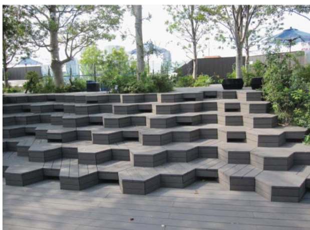
写真 1 混練型 WPC を使った屋外製品事例 (上: 函館競馬場, 下: 東急プラザ表参道原宿) (提供: エア・ウォーター (株))
