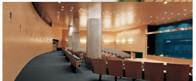
図3 多孔質吸音材料との組み合わせ(上:背面が多孔質吸音材料, 下:施工事例) http://www.archiexpo.com/prod/fantoni/product-52836-280250.html (最終検索 2015年10月20日) (性能部 保存グループ 平間昭光)
