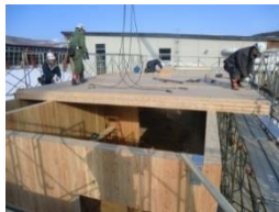
屋根パネルの施工
