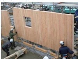
防腐処理土台と1階壁パネルの施工
