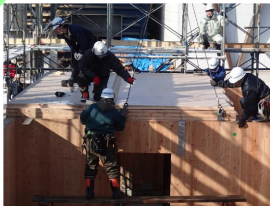
CLTの現場施工の様子 (「林産試ニュース」より)
