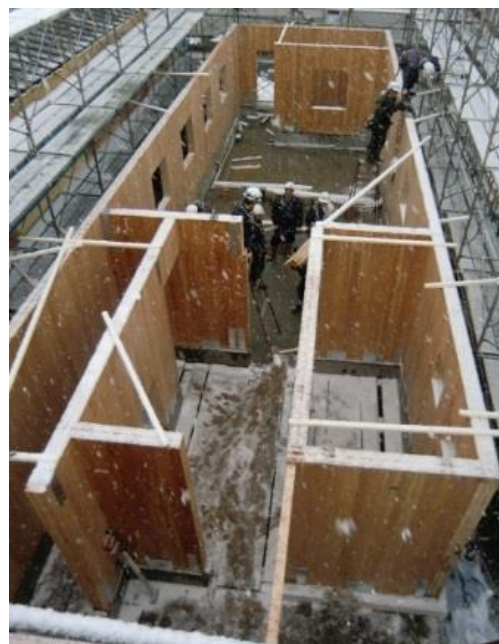
セミナーハウス建設工事
