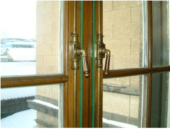
写真9 日本郵船小樽支店の窓
