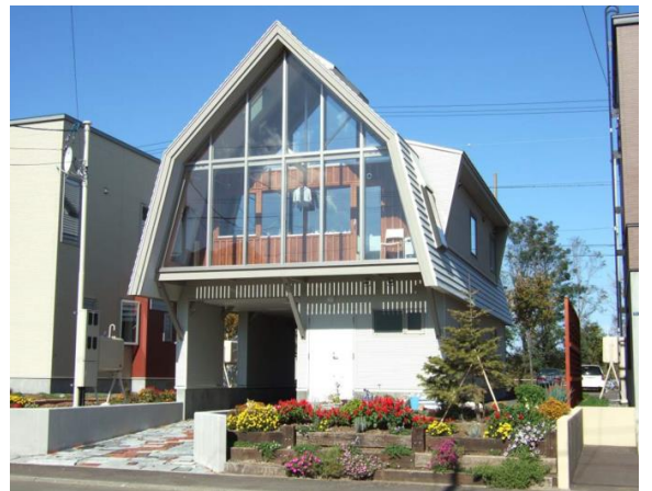
写真19 星置の家 竣工:2005年
