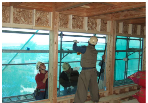
写真15 サッシの取り付けは5人掛かり
