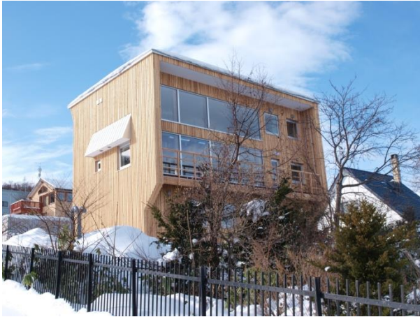
写真12 銭函の家 竣工:2009年
