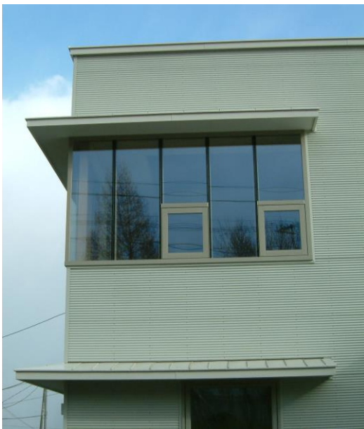
写真4 木製サッシを保護する庇
