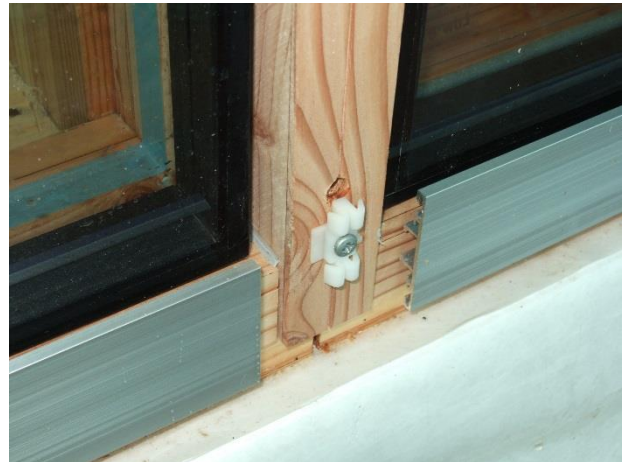
写真5 アルミクラッドタイプの木製サッシ
