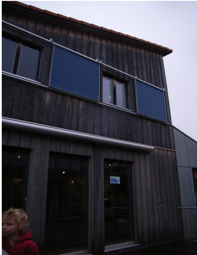
写真8 軒の出が少ない外壁
