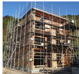
国内初のCLT建築(高知県)
