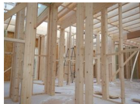
トドマツ製材による2×4住宅
