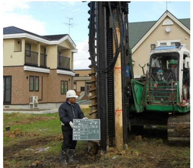
写真4 地盤補強杭工事の例（岩見沢市）
