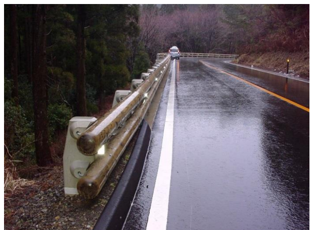
写真2 木製ガードレール（宮崎県）
