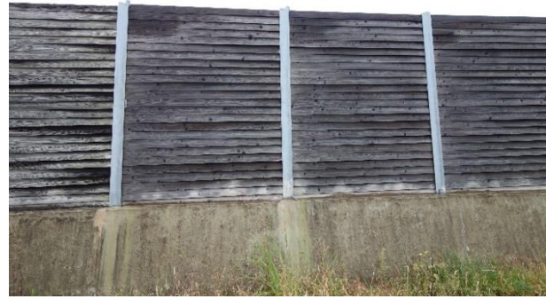
写真3 30年経過の木製遮音壁（長野県）
