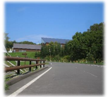
ガードレール
