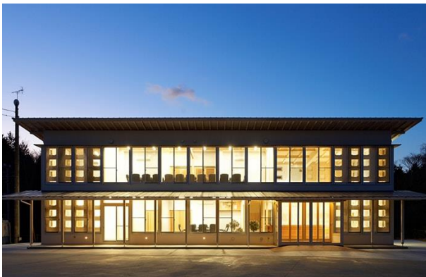
写真1 完成後の外観
