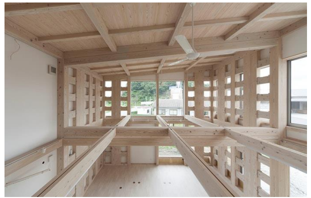
写真6 建方終了後の内観
