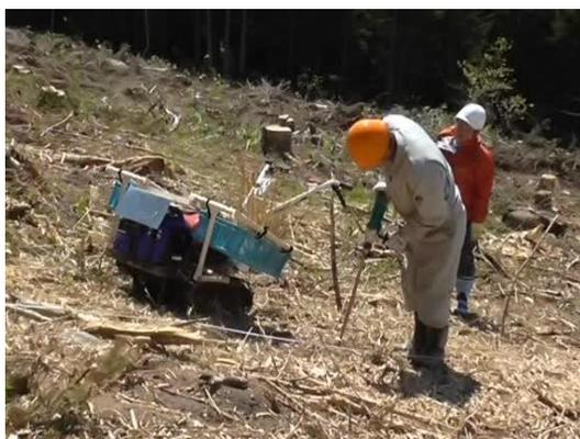
図3 電動ドリルを使った植栽の様子
