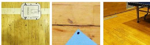
図3 支柱差し込み穴周辺の凹み 図4 収縮による目地の割れ 図5 卓球使用に伴う塗装剥がれ
