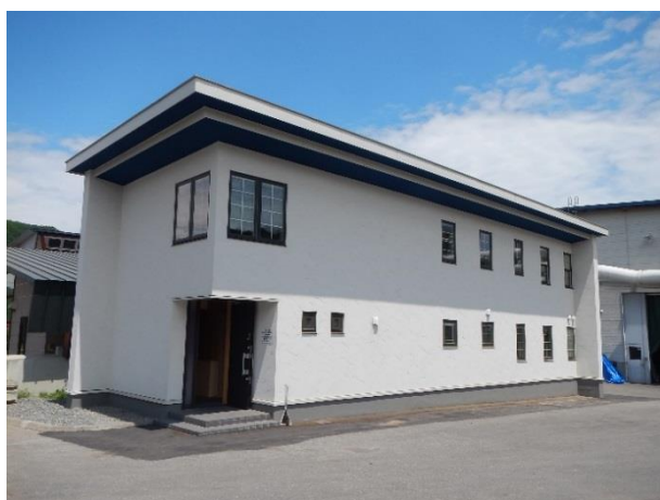
写真2 道産カラマツCLTによる建築物
