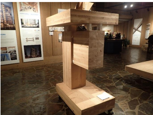
写真3 耐震性を考慮したCLTの接合
