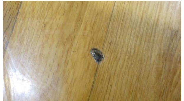
写真27 基材が露出した凹みを塗装する
