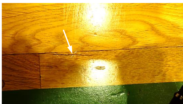
写真3 落下衝撃によると考えられる割れ
