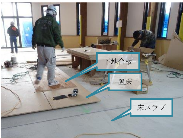
写真6 床下地の施工状況
