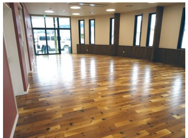
写真8 床の仕上がり
