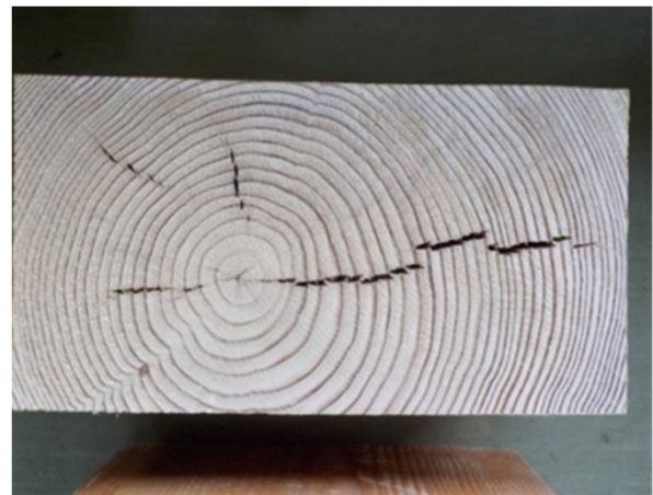
写真2 乾燥により生じた内部割れ
