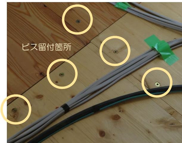
写真7 床パネルのビス留め付け状況
