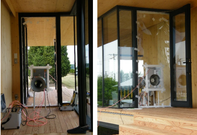
写真3 送風機設置状況（左：室内，右：屋外）
