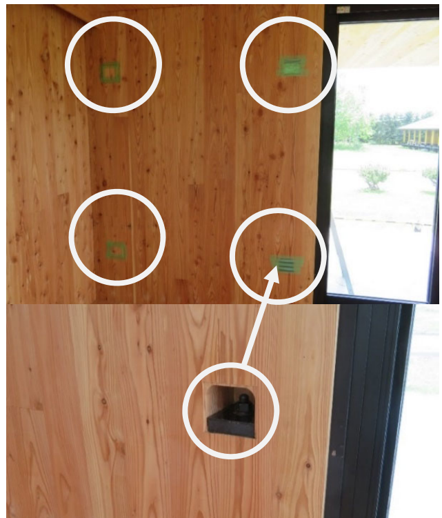
写真6 南東壁面の外皮貫通孔の目張り状況
