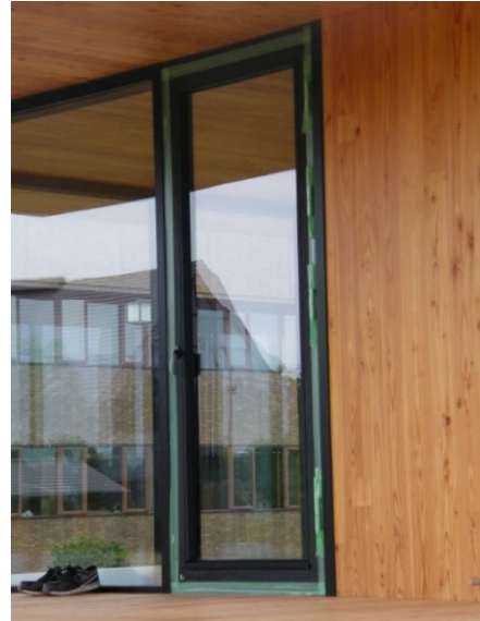
写真5 開口部2の目張り状況
