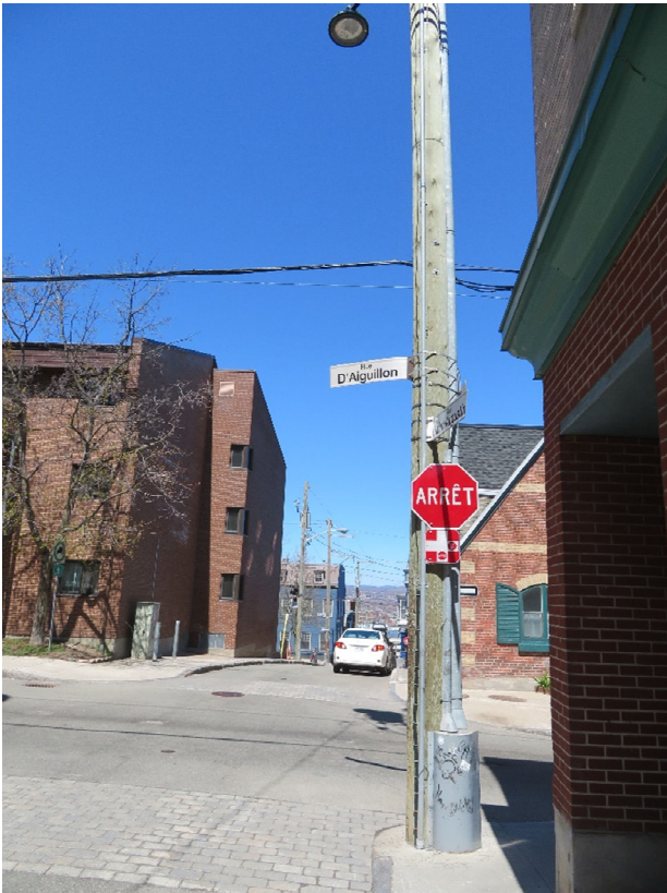
写真10 保存処理木材を用いた電柱
