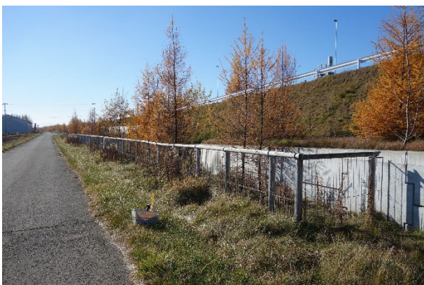
写真 木製立入防止柵
