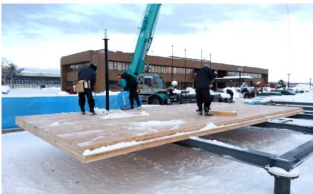
写真13 床パネルと連続的にはね出したテラス部
