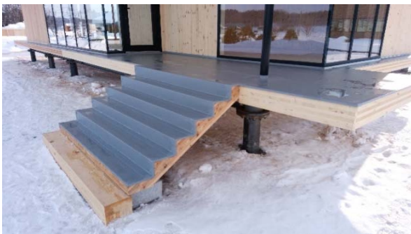
写真25 屋根面と屋外床面の防水工事
