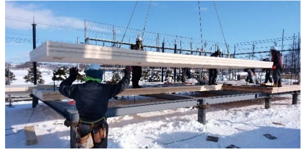
写真6 床パネルの施工
