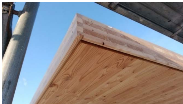
写真26 パネル木口に取り付けた被覆板
