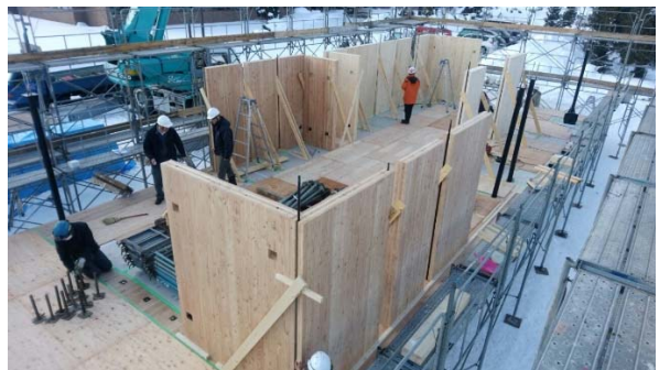
写真8 壁パネルの施工
