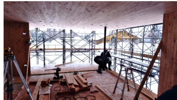
写真18 屋根上の逆梁と鉄骨柱による大開口
