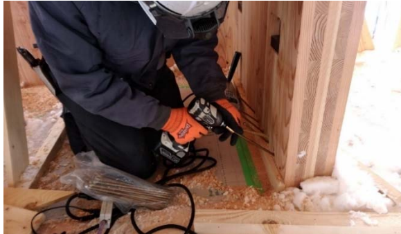
写真16 斜めビス式せん断接合
