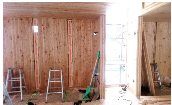
写真23 壁パネル間の断熱気密施工
