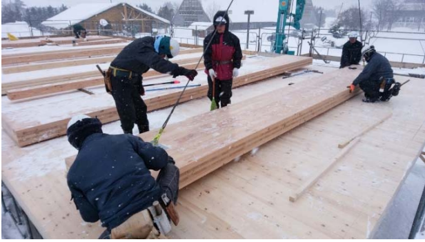
写真11 屋根上の逆梁パネルの施工
