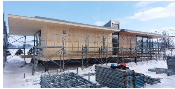
写真17 全方位に張り出した庇とフラット屋根
