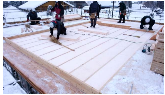
写真21 屋根パネル上の外断熱施工
