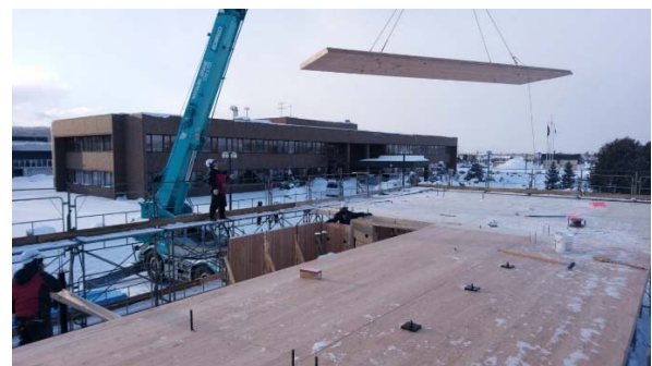
写真9 屋根パネルの施工
