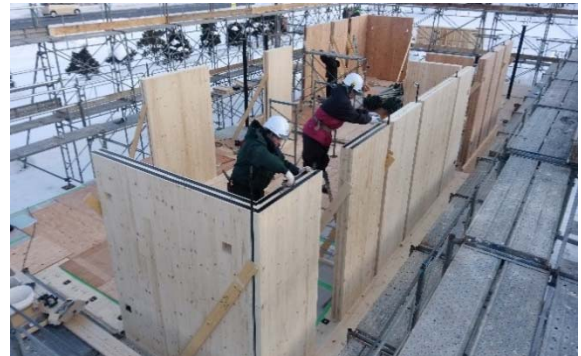
写真22 壁パネル上部の気密施工
