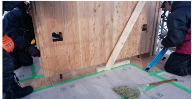
写真14 引きボルト式引き抜き接合
