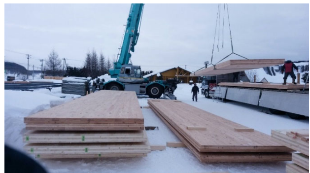
写真4 CLTパネルの荷下ろし
