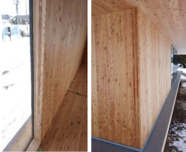
写真20 屋内外で“現し”とした外壁CLT
