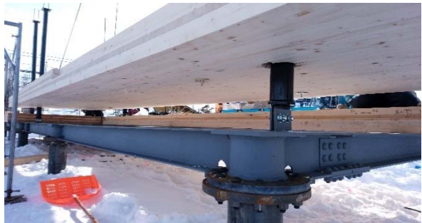
写真7 鉄骨円柱と床パネルの納まり
