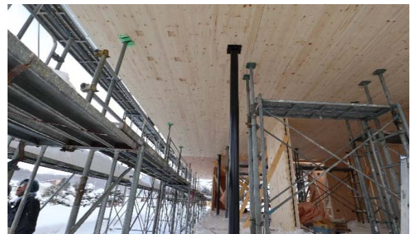
写真10 屋根パネルを仮支持する支保工
