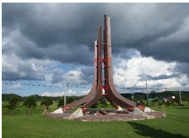
図2 解体前シンボルタワー外観（2017年）
