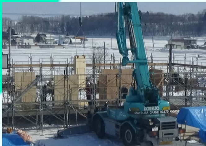
Hokkaido CLT Pavilionの建築の様子（林産試験場構内）
