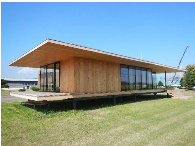
図1 カラマツ・トドマツCLTの高剛性を活かした軒のはね出し (林産試験場のCLT実験棟<sup>2)</sup>)
