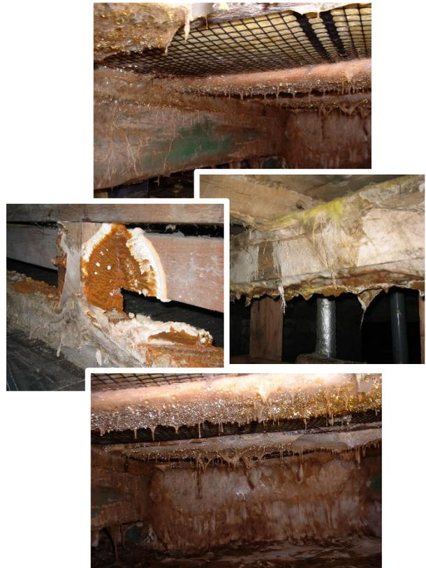
写真2 床下で腐朽菌が蔓延した事例
