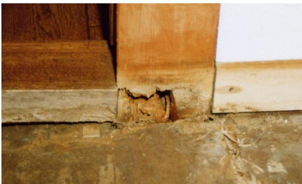
写真1 畳で隠れた部分に発生した腐朽事例
