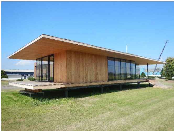
図1 カラマツ・トドマツCLTの高剛性を活かした軒のはね出し (林産試験場のCLT実験棟 2) )
