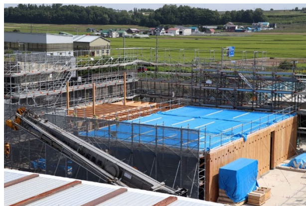
【8月2日現在の工事の状況】
