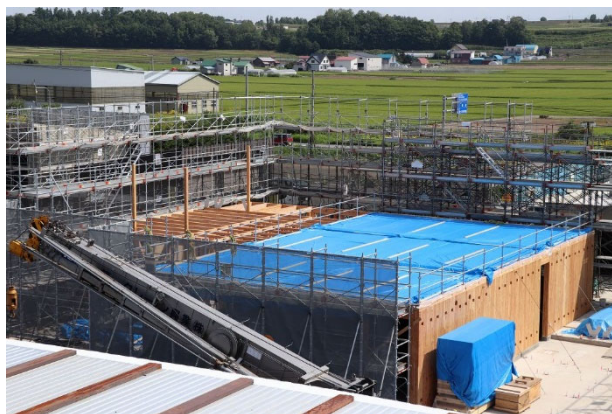
【8月2日現在の工事の状況】
