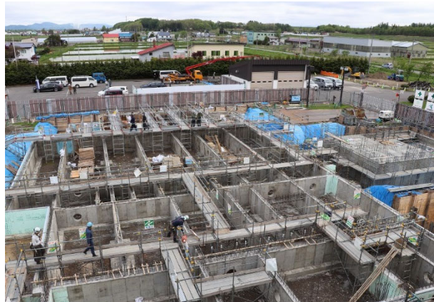
【工事の様子（5月26日撮影）】
