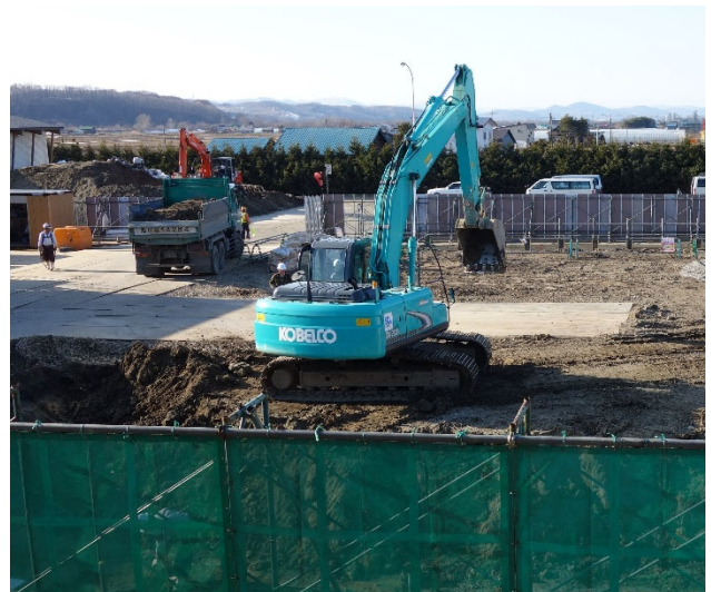
【北森カレッジ新校舎建設工事の様子】
