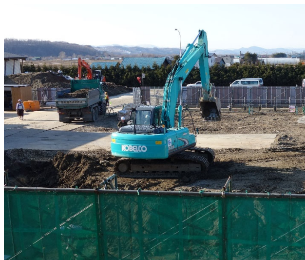
【北森カレッジ新校舎建設工事の様子】
