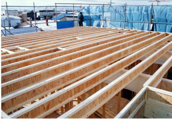
図 2-9-2 道産 I 形梁の施工試験 (旭川市戸建て住宅)
