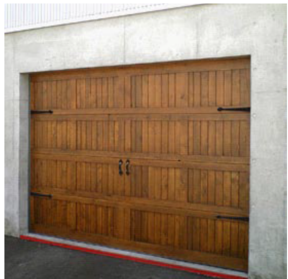
図 2-2-12 開発した木製防火シャッター
