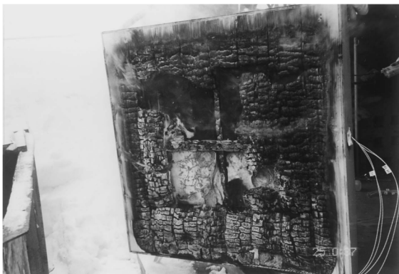
図 2-2-10 木造外壁の耐火試験終了後
