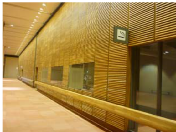
図 2-2-11 JR 旭川駅の新駅舎の様子 （準不燃タモ材を内装材として使用）
