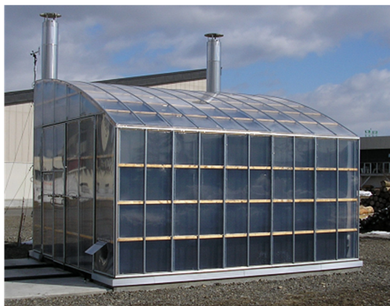
図 2-7-6 パッシブ太陽熱利用乾燥装置
