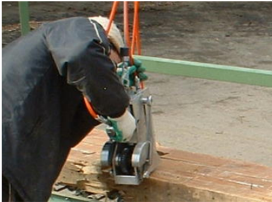
図 2-11-17 釘抜き装置を用いた作業の様子
