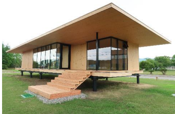
図 2-1-8 林産試験場内に建設された CLT 性能評価実験棟 "Hokkaido CLT Pavilion"
