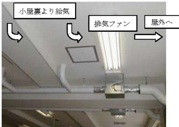
図 2-3-3 林産試験場型小屋裏排気システム
