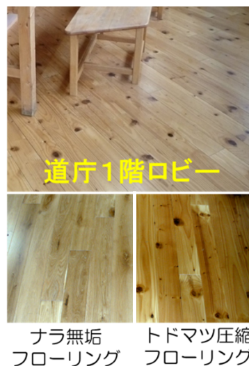
図 2-11-2 トドマツ圧縮フローリングの試験施工（下・左：対照のナラフローリング）
