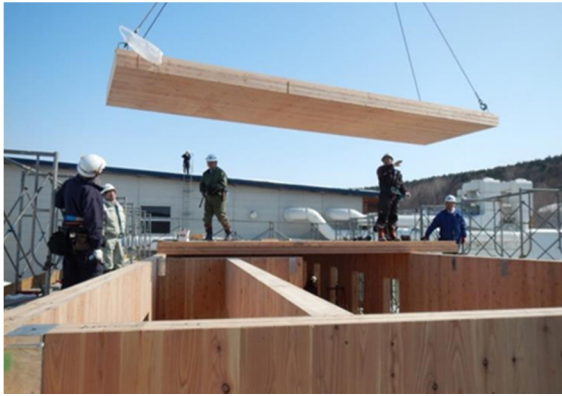
図 2-9-11 カラマツ CLT 建築物の施工風景 (北見市)
