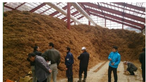
図 2-6-12 チップ乾燥システムの一例 （南富良野町）
