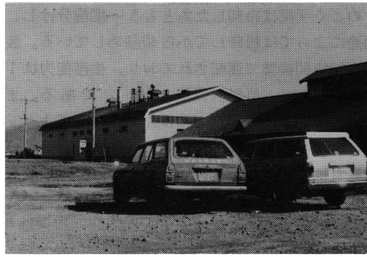
炭化工場（左側）と製品倉庫（右側）
