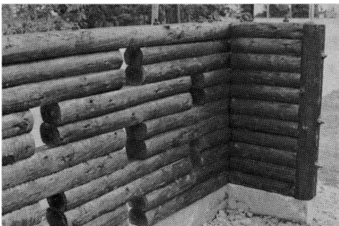
写真-4 カラマツ小径材で作ったへい
