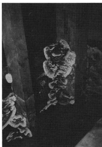
図14 ナミダタケの被害
