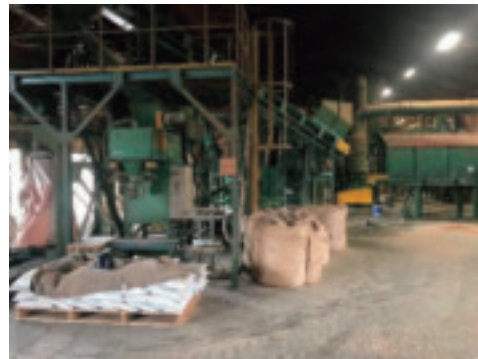
写真 2-1-1-2 ペレット製造施設
