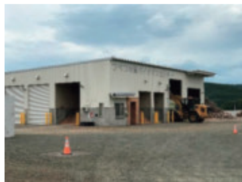
写真 2-1-1-4 津別町木質バイオマスセンター
