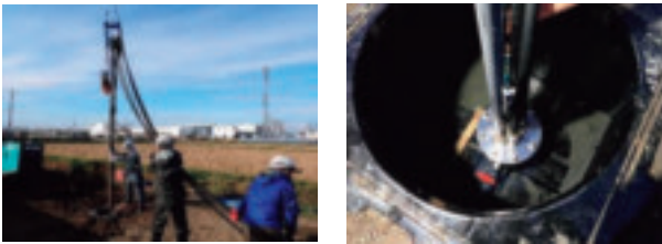
井戸への採熱管の挿入 井戸へのフランジの接続 写真 3-3-3-3 採熱管設置状況
