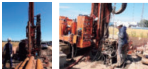
孔の掘削 電気検層 写真 3-3-3-2 孔の掘削, 電気検層の状況
