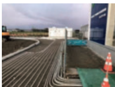
写真 3-3-3-1 融雪箇所における温水配管施工状況
