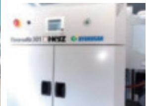
(b) 木質ボイラー
