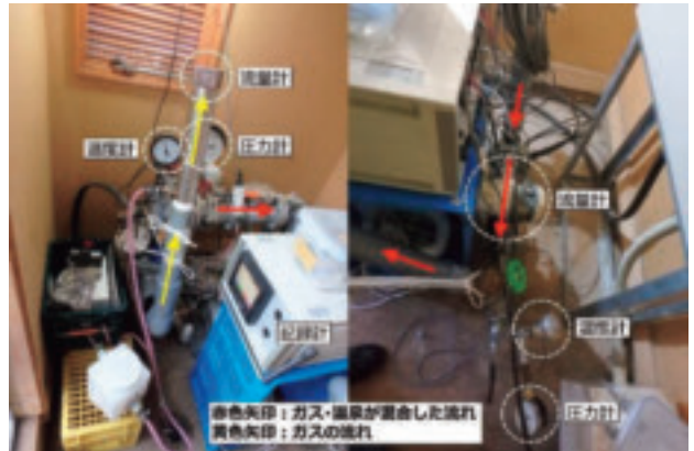
図 4-2-3-1 新町 1 号井揚湯試験 (試験 2020) の全景
