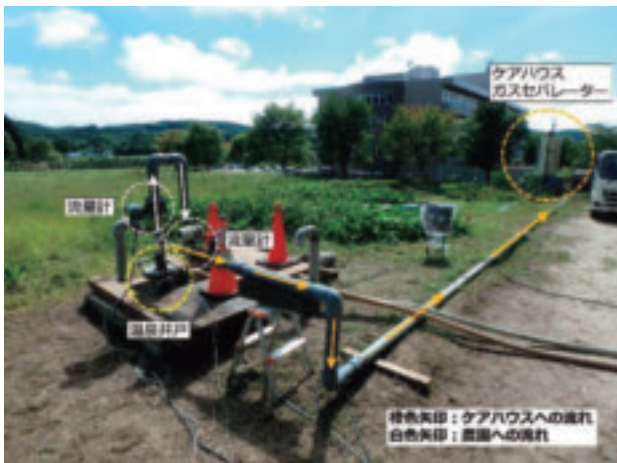
図 4-2-2-1 銀河の湯揚湯試験の全景
