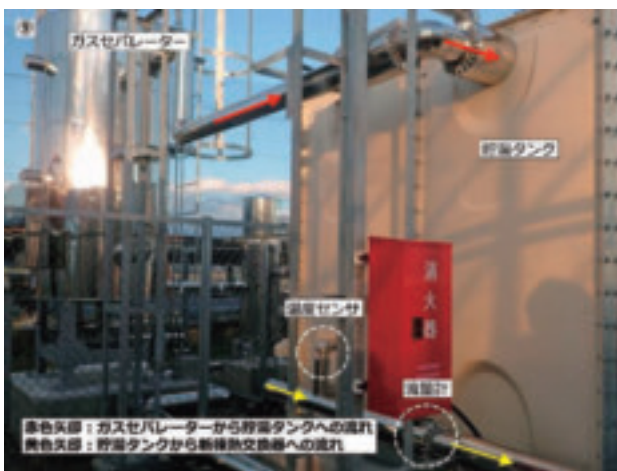
図 4-1-3-13 ガスセパレーターと貯湯タンクの位置関係
