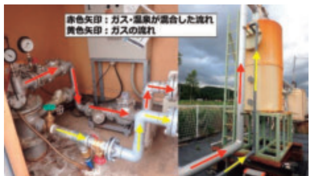
図 4-2-3-3 新町 1 号井揚湯試験 (試験 2022) の全景
