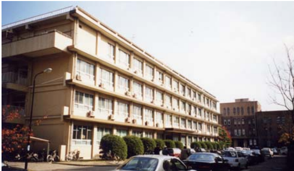
写真 1 九州大学大学院地球資源システム工学専攻の建物
