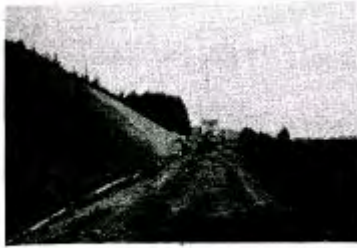
写真-1 ハイドロシーダーによる 種子吹付工
