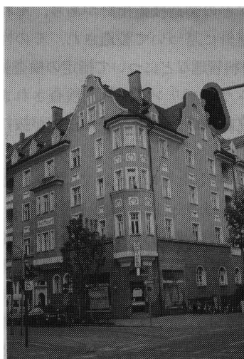
写真20 ローゼンハイムの古い窓を取り付けた住宅
