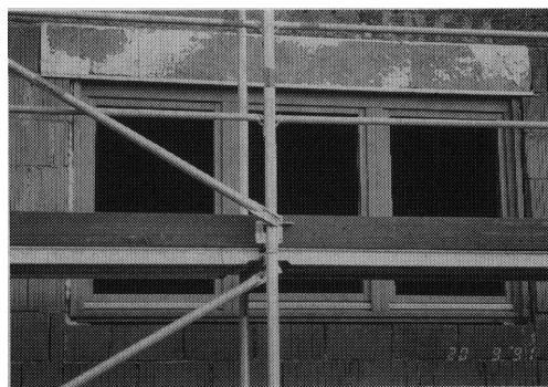
写真22 外付けシャッターを取り付けた断熱ブロック組積造の開口部
