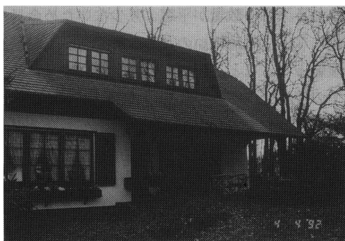
写真 2 屋根窓（牛目窓）の使用例
