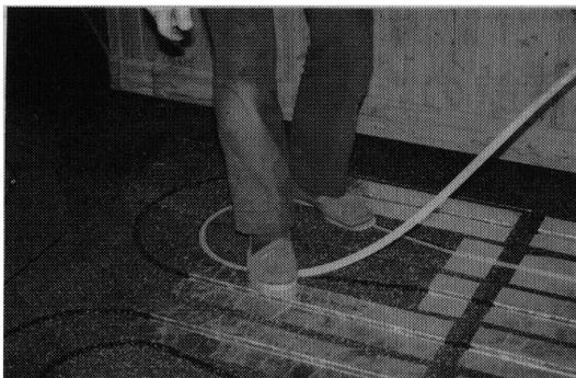
写真1 温水パイプの施工
