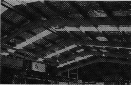
写真 21 倉庫の合板ガセットを用いた梁
