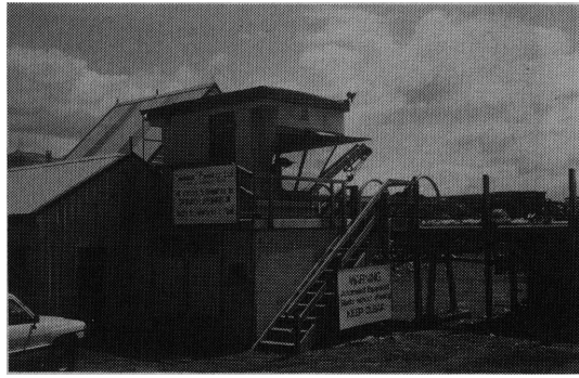
写真 24 港に設置されたリングパーカー
