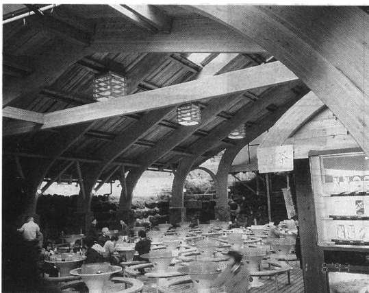
写真7 集成材構造によるソーメン流しの施設
