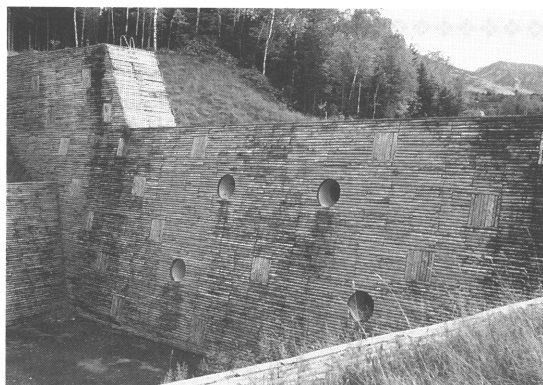
写真8 竣工後約5年が経過した砂防ダム
