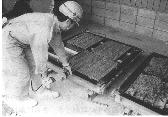
写真7 コンクリートの打設
