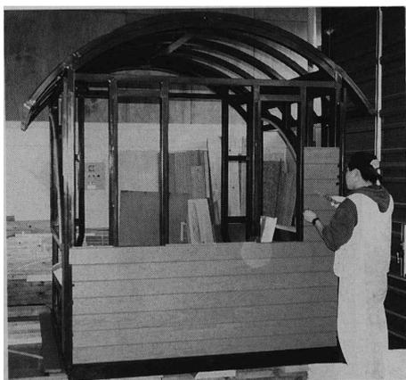
写真4 外装材の取り付け
