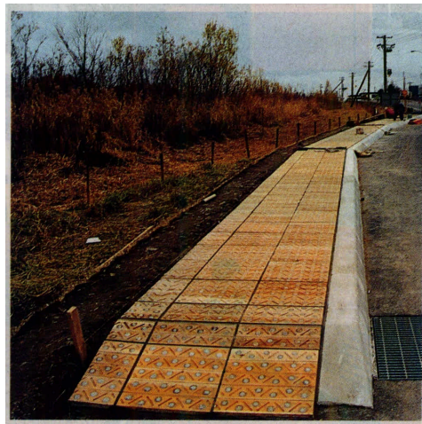
バス停留所（ラーチペーパーブロック） 旭川市 (株)旭ダンケ カラマツ DDAC加 圧注入 旭川土現 1993年
