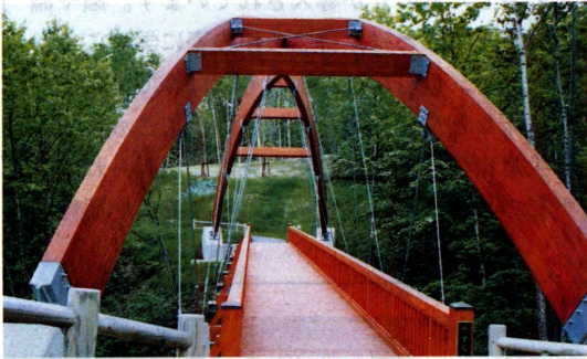
アーチ橋「やすらか橋」 丸加高原(滝川市) (株)シビテック/トリスミ集成材(株) ベイマツの大断面集成材 表面保護着色剤塗布 1994年 人道橋, 橋長30m, 有効幅員2.15m
