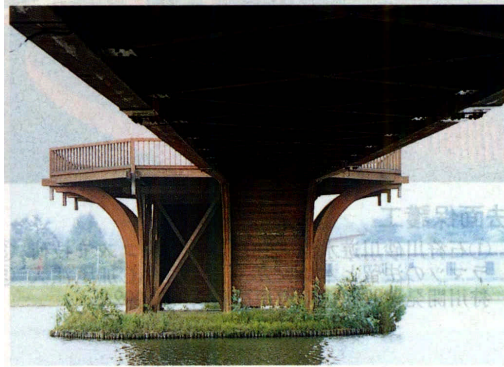
3径間ラーメン橋「やすはる橋」 (我が国における近代木橋の先駆的な役割を果たした橋) 軽井沢町 (株)長野技研/青藤木材工業(株), 上田第三木材(合資) カラマツの大断面集成材 表面保護着色剤塗布 1987年 人道橋, 橋長131.1m (最大径間56.8m), 有効幅員3m
