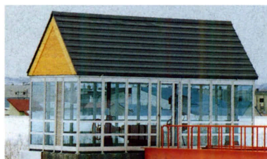
樋門上屋（ひもんうわや：用水の取り入れのため堤防を横断して作られた水路の水門上の建物） 農事会樋門（月形町） (株)エナジーノ(有)ヨシザワ カラマツ 1994年（写真提供：(有)ヨシザワ）
