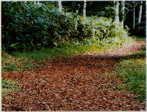
遊歩道（木質舗装） （カラマツチップを30cmの厚さに敷設） 白金自然休養林（美瑛町） 地元チップ工場 カラマツ なし 美瑛町 1988年
