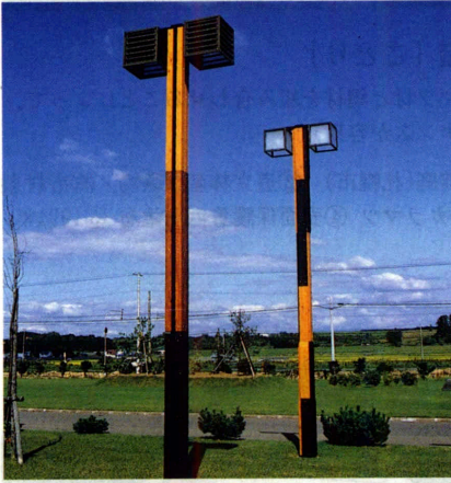
街路灯 (鋼製の照明柱にカラマツ材をビス止め)
