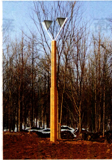
街路灯 (鋼製のポールにカラマツ材をビス止め) 桜岡公園(旭川市) (株)シスコン・カムイ カラマツ 表面保護着色剤塗布 1993年
