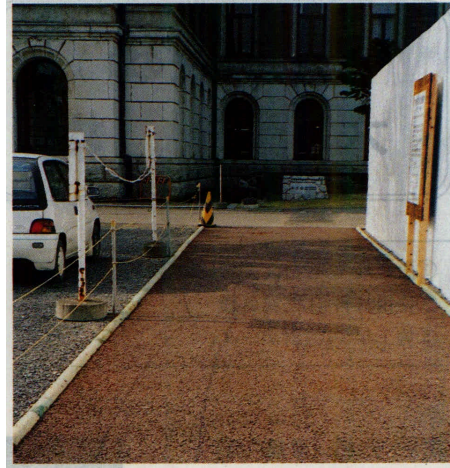
構内道路（木質舗装） （チップとゴム入りアスファルト乳剤を混合したもので、透水性あり） 群馬県庁本庁舎（前橋市） ニチレキ(株) カラマツ、スギのチップ なし 群馬県 1994年 （写真提供：群馬県林務部林産課）
