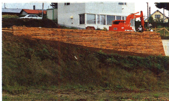
擁壁 旭岡(旭川市) 個人 カラマツ 36m 3 1988年
