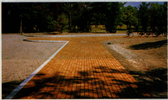
歩道（木製舗装：プラスチック枠に木レンガ挿入） 名寄公園（名寄市） (株)サトウ カラマツ 防腐剤薬液浸漬 名寄市 1992年 （写真提供：(株)サトウ）
