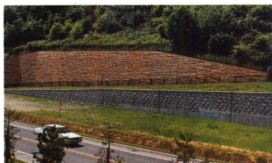
斜路工 国道12号線バイパス(旭川市) 旭川市 カラマツ 340m 3 1992年
