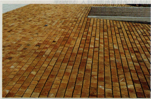
アプローチ（木レンガ舗装） 木と暮らしの情報館（旭川市） 道立林産試験場 エゾ・トドマツ CCA加圧注入 道立林産試 験場 1988年
