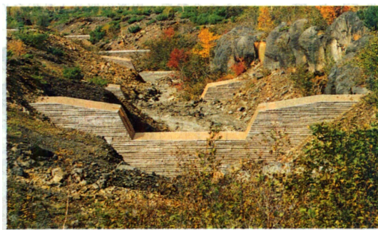
砂防ダム 望岳台沢(美瑛町) 旭川営林支局 カラマツ 234m 3 1992年
